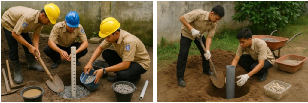
Gambar 1. siswa praktik membuat sumur resapan
